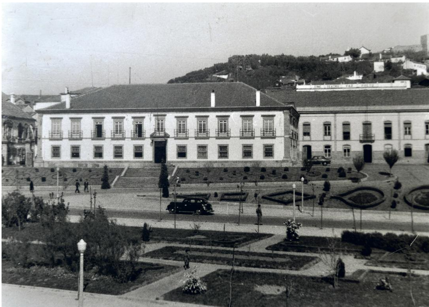
Fachada do palacete dos Viscondes de Portalegre onde esteve instalado o Governo Civil de Castelo Branco até ao seu encerramento em 2011 (1952)
